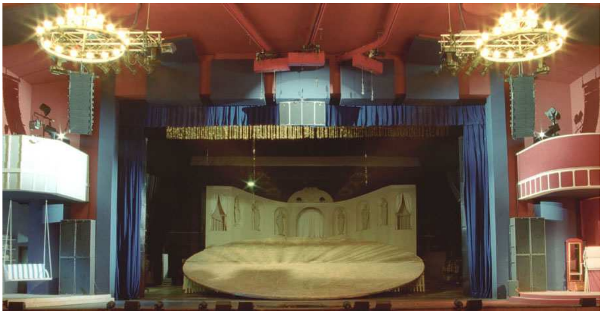
Figure 31: Cluster central ARCS accroché (dV-DOSC FOH gauche/droite)
